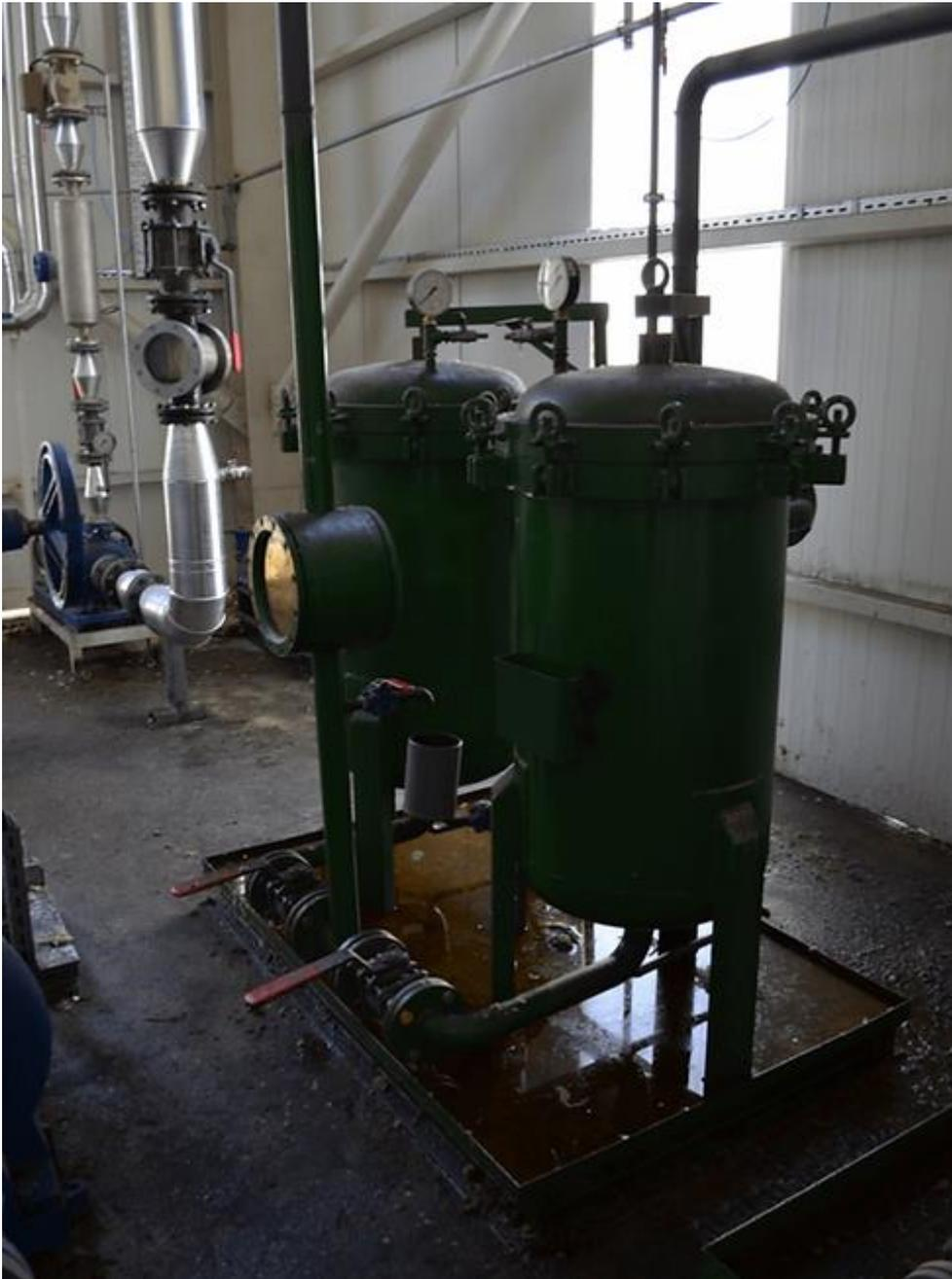
Однослойный или многослойный, в основном используется для окончательной очистки продукта. Облегчает использование кассет быстросъемного типа.
