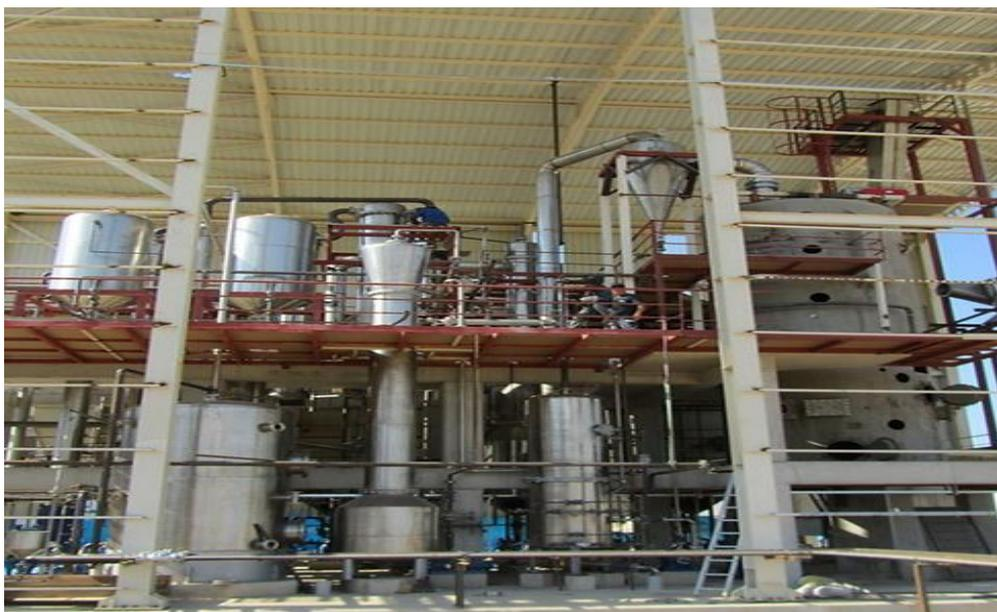
Система, используемая для извлечения газа-растворителя (гексана), который испаряется и выводится в систему экстракции путем конденсации. Затем происходит процесс физического разделения водно-жидкостного раствора и растворителя (гексана). Затем растворитель (гексан) может быть направлен в гексановый водоотделитель, а сточные воды можно безопасно выведены с установки.
