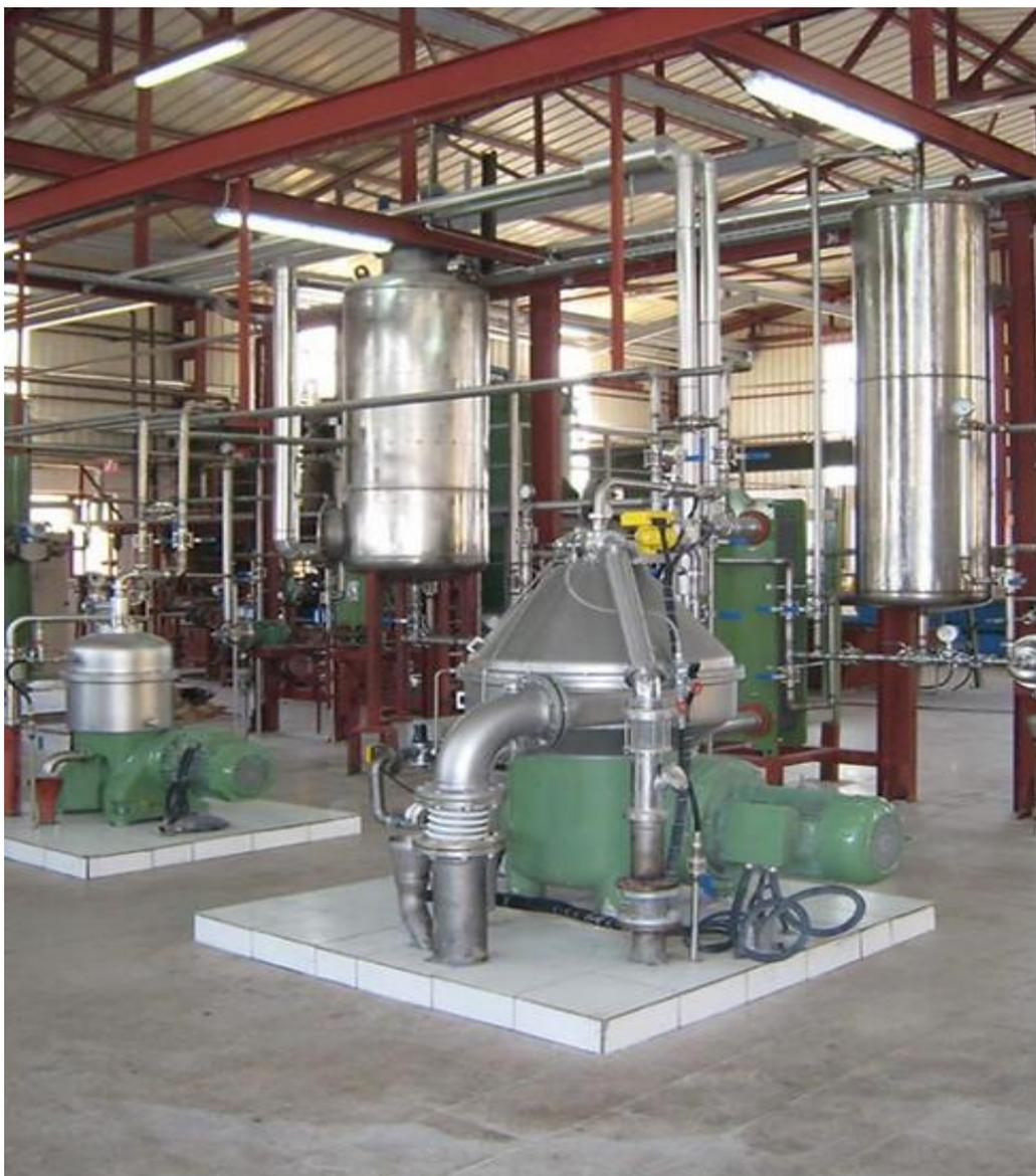
Это процесс, основанный на очистке твердых и жидких масел от частиц, вызывающих нежелательный запах и аромат. В этом процессе вода и пар впрыскиваются в масло при высокой температуре и под вакуумом.
