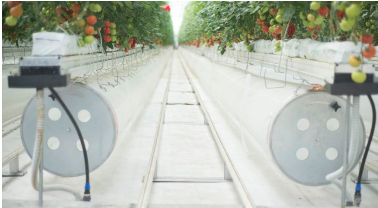
AIR DUCTS / ВОЗДУХОВОДЫ
