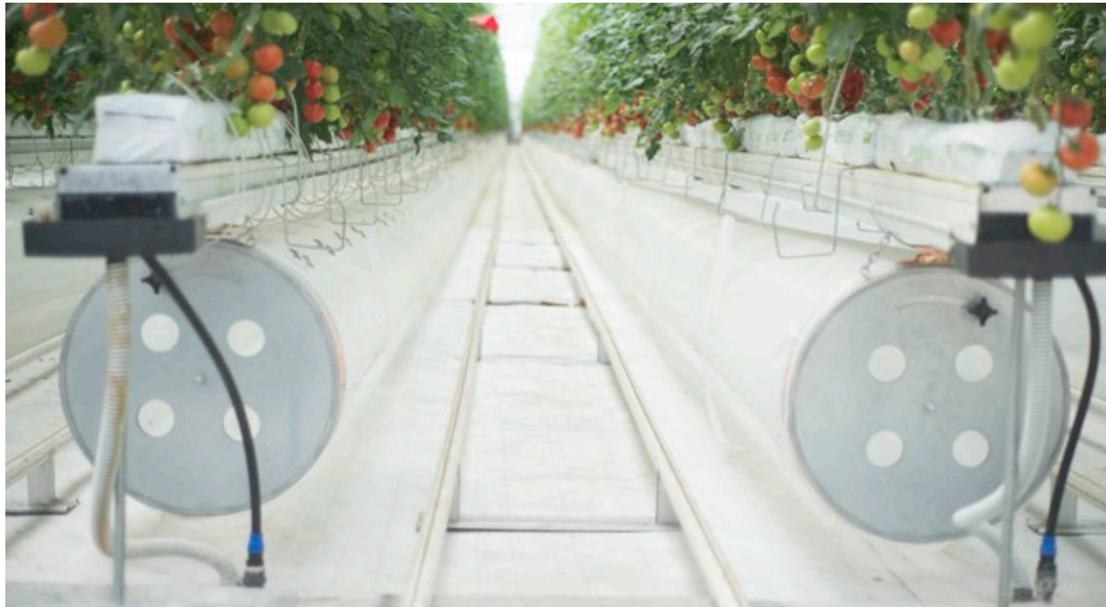
AIR DUCTS / ВОЗДУХОВОДЫ
