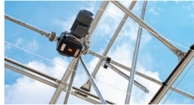
ÇİFT EMNİYET SWITCHLİ MOTORLU REDÜKTÖR VE KRAMİYER DİŞLİ SİSTEMİ
